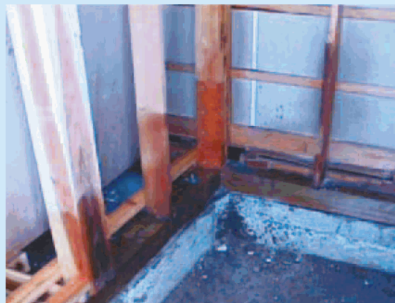
①土台・柱の新設状況。 防蟻・防腐処理を施す。
