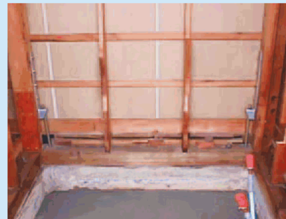
①木工事完了後、土間コンクリート打設。
